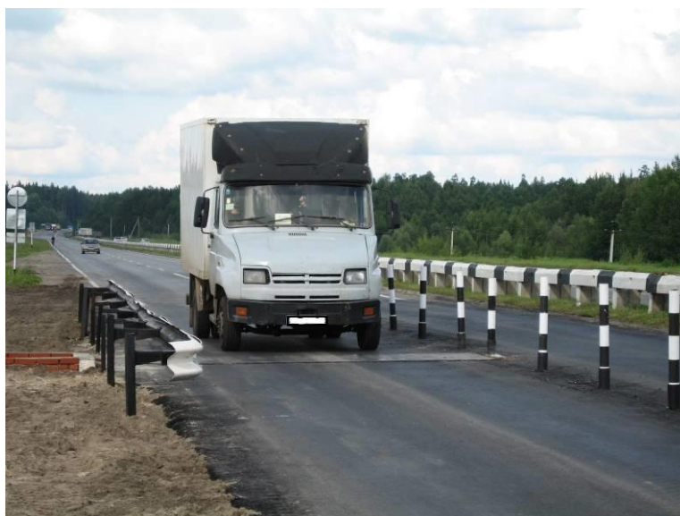
Рисунок 3 - Общий вид ГПУ в дорожном полотне
